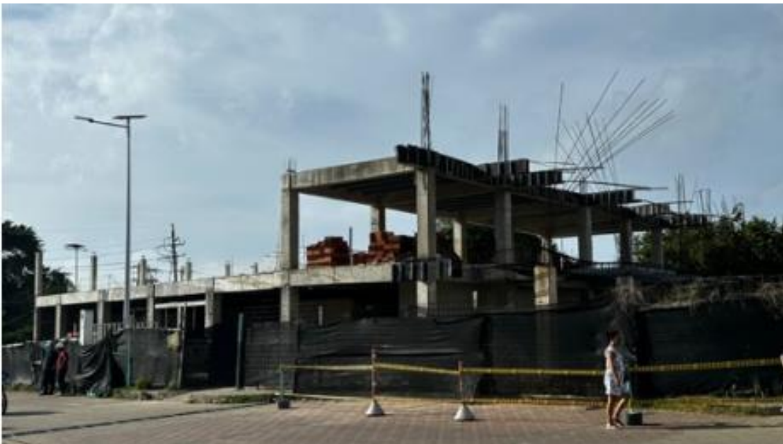
GRÁFICO 14. FOTOGRAFÍAS DE LA CONSTRUCCIÓN DE LA NUEVA TORRE DEL HOSPITAL CLARENCE LYND NEWBALL EN SAN ANDRÉS ISLA
