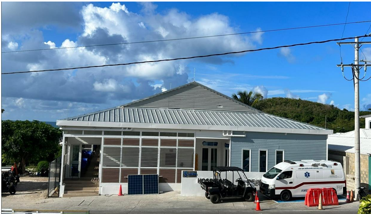
GRÁFICO 4. FACHADA DEL HOSPITAL LOCAL DE PROVIDENCIA DESPUÉS DE LA RECONSTRUCCIÓN
